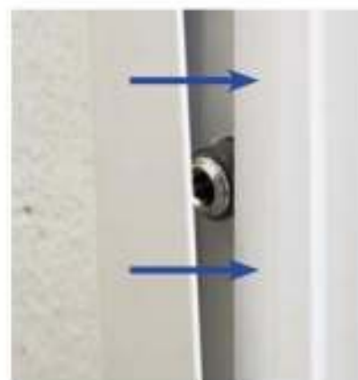
profilo a scatto per la copertura delle viti di fissaggio
